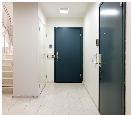
I Skatteskrapans kollegielejligheder benyttes S33 med elektronisk låsning
