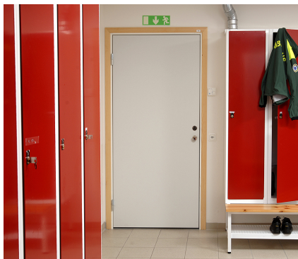
Massivdør med laminatflade og plastkant i omklædningsrum
